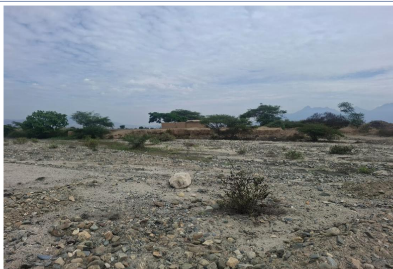
FIGURA N°02: ZONA COLMATADA , SE REQUIERE DESCOLMATAR EL CAUCE Y EN AMBAS MARGENES CONFORMAR BORDOS PARA MAYOR PROTECCION
